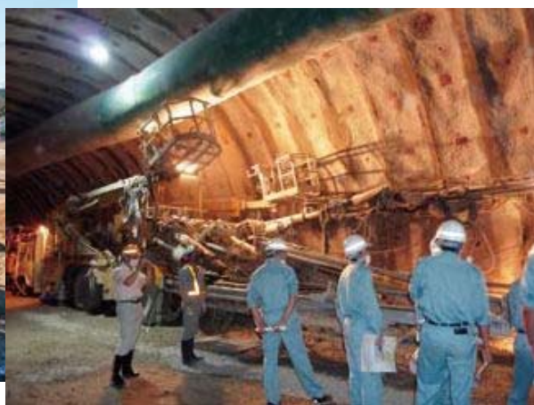
トンネル工事現場見学 (平成23年6月)
