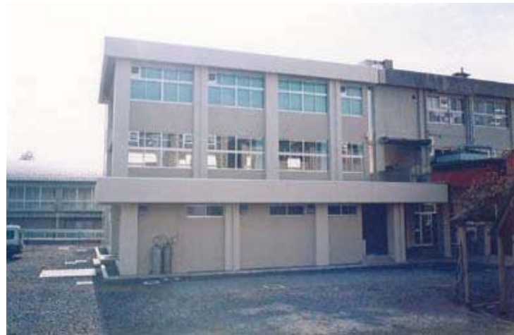
産振棟3階建竣工（平成9年）
