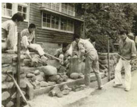
旧玄関口改修実習 (昭和44年)
