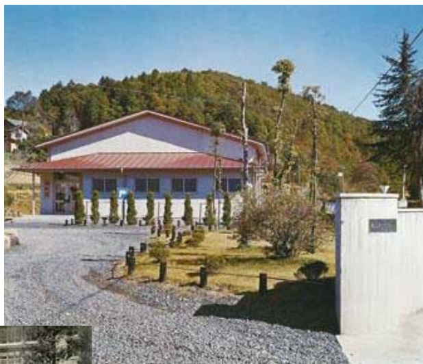
格技場完成（昭和46年）
