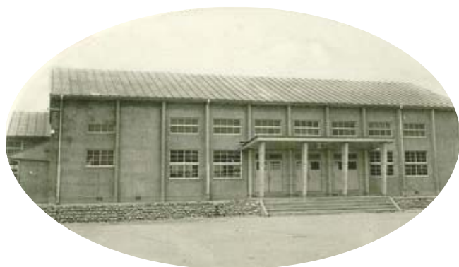
講堂完成（体育館）（昭和29年）
